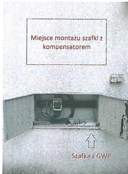
Rys. 1 Miejsce montażu szafki z kompensatorem
